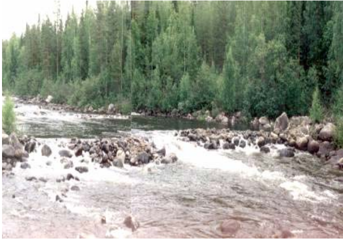
Figur 4 Grunddamm anlagd i Juktån.
