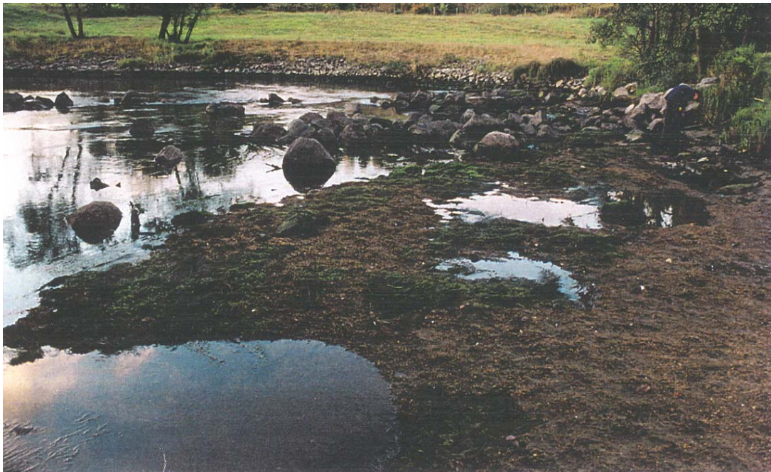
Figur 3 Torrläggning av strömfåra nedströms Jonsereds kraftverk innan installation av nödvattenlucka.
