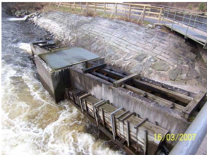
Figur 6 Övre fisktrappan vid Jonsereds kraftverk. Träkonstruktionen som syns i bilden är den gamla ålyngelledaren.
