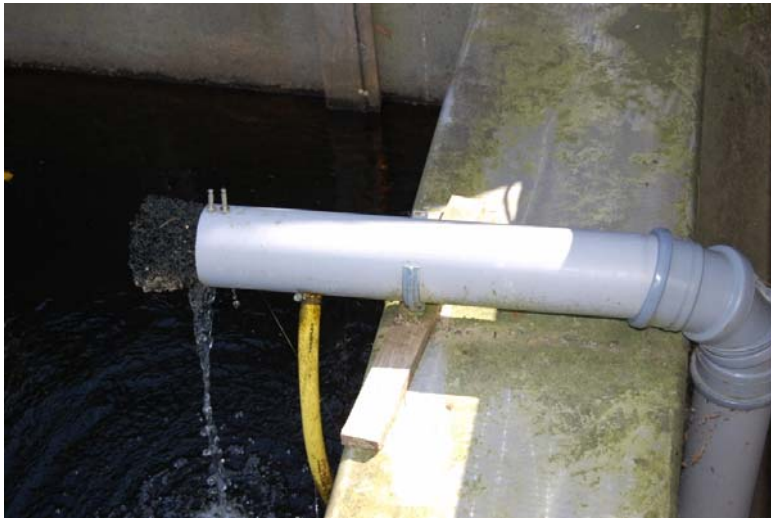
Figur 8 Ny konstruktion av ålyngelledare som används i Säveån.
