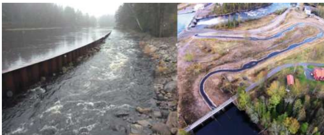
Figur 2: Ett inlöp i Mörrumsån (vänster) och ett omlöp (biokanal) i Västerdalälven (Foton av Olle Calles och Fortum AB).
